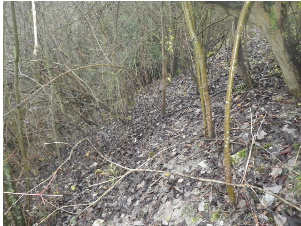
Vue du talus (15/12/2014)
