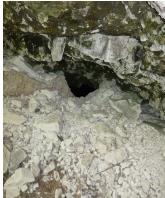
Photographie de l'entrée d'une galerie au droit de l'éperon rocheux (localisation prise de vue ★ )
